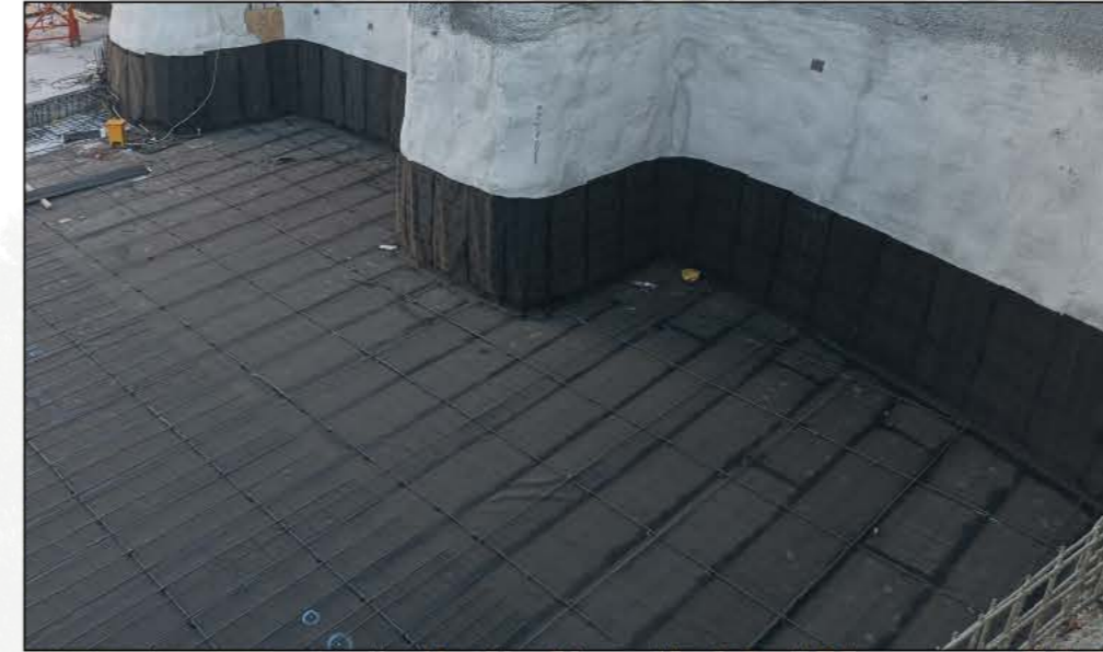
3 Temel Altı İzolasyon ve Perde İzolasyonu Genel Görünüş
