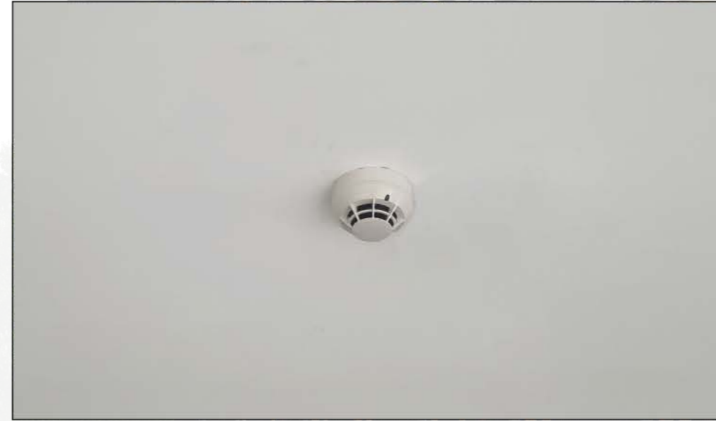
7 Daire İçi Yangın Algılama Sistemi
