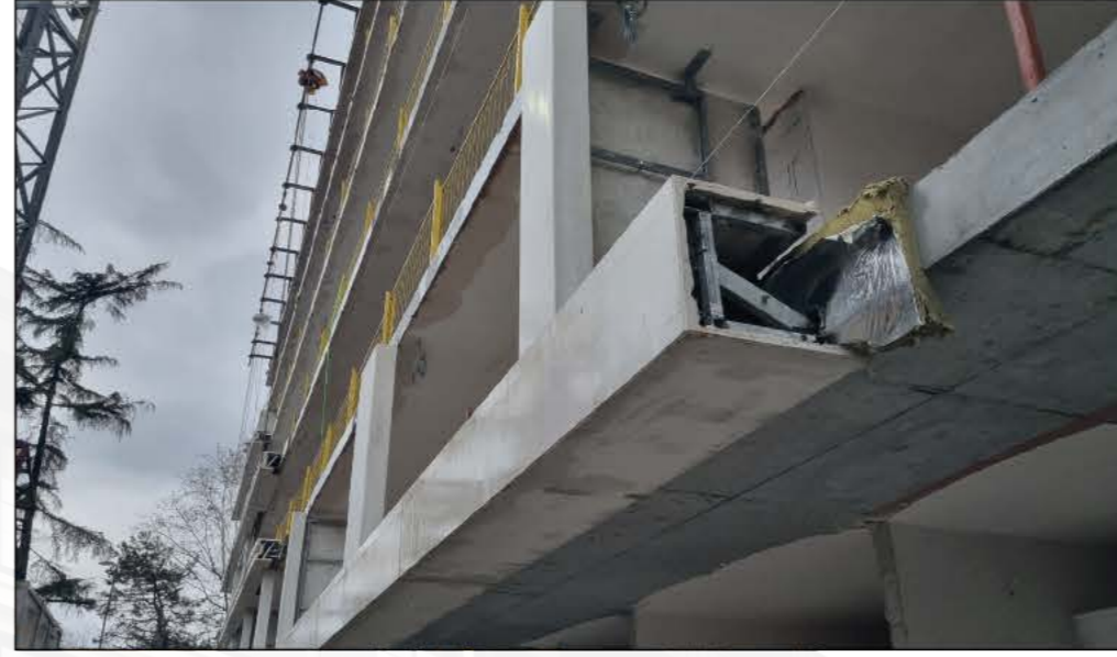
2 Kat Silmesi ve Taşyünü Montajı
