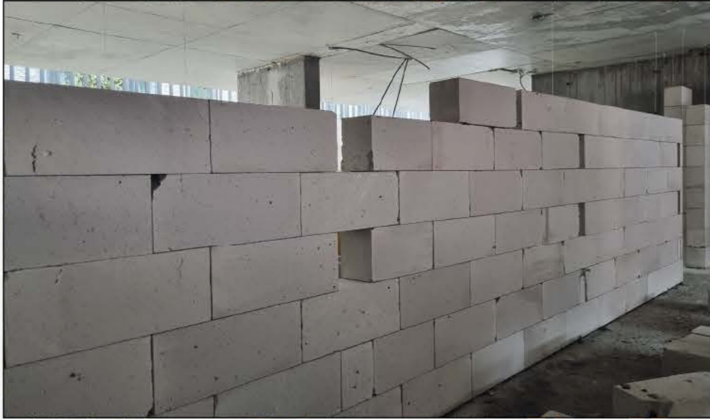
3 Gazbeton Blok Duvar Örülmesi ve Kilit Sistemi
