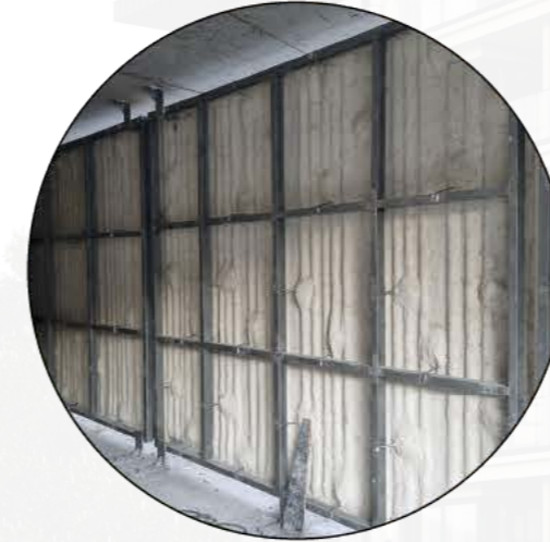
GRC PREKAST CEPHE PANELİ DAİRE İÇİ GÖRÜNÜŞÜ - Galvaniz Profil Taşıyıcılar -
