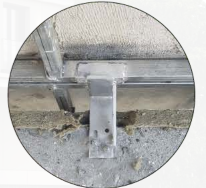
Detay 3 Panel Ankraj Detayı
