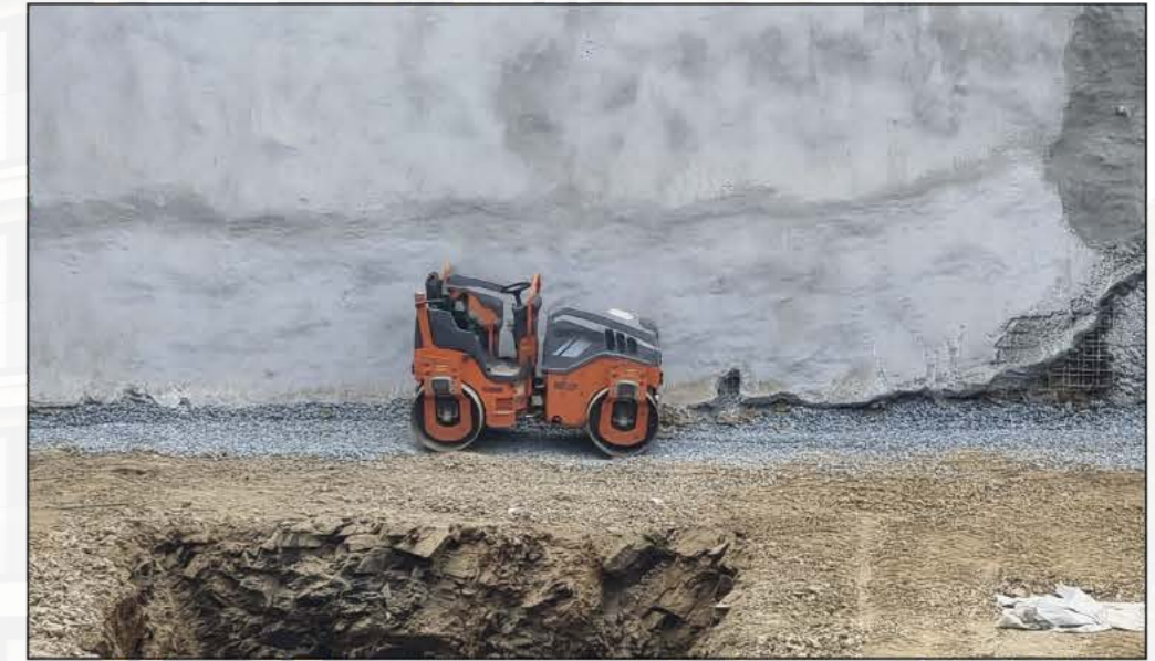
4 Silindir ile Zemin Sıkılaştırılması
