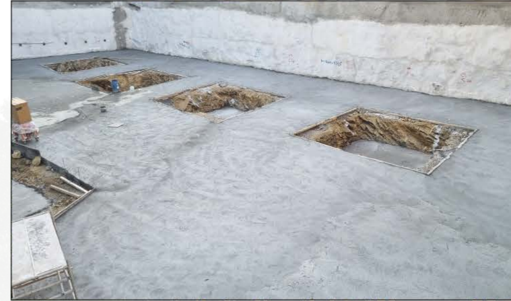
3 Grobeton ve Asansör Kuyuları
