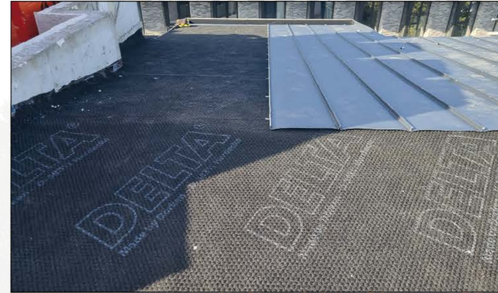
3 Delta Trela Buhar Dengeleyici Örtü Serilmesi
