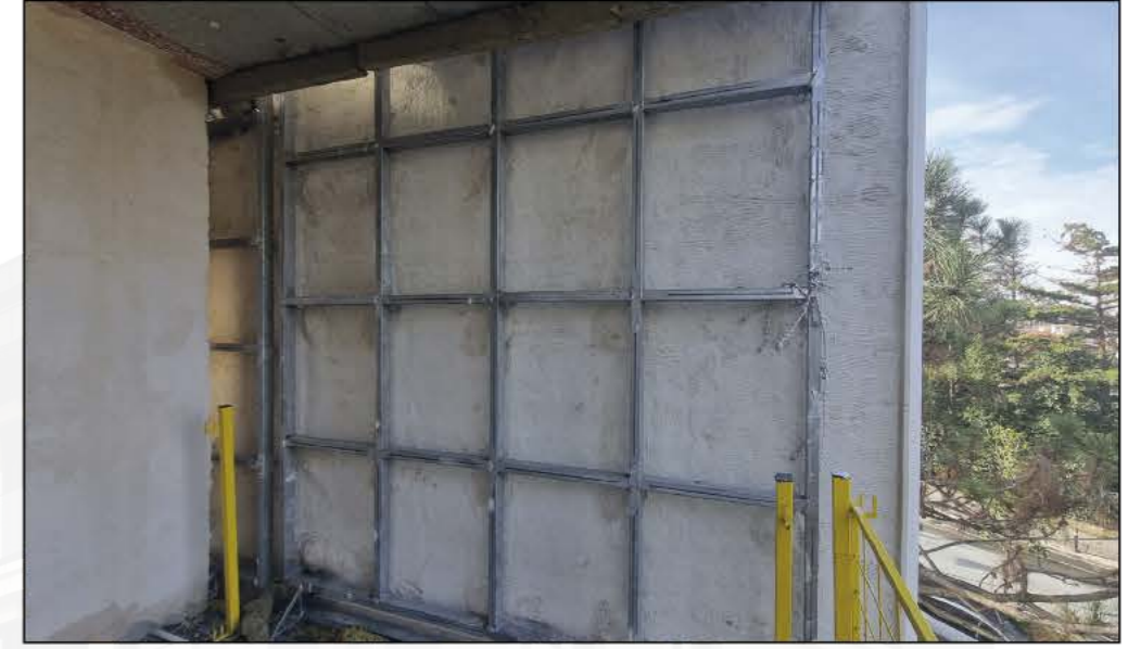
6 Cephe Panel Montajı İç Cephe Görünüşü
