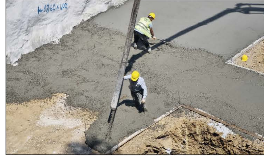
1 Grobeton Dökülmesi
