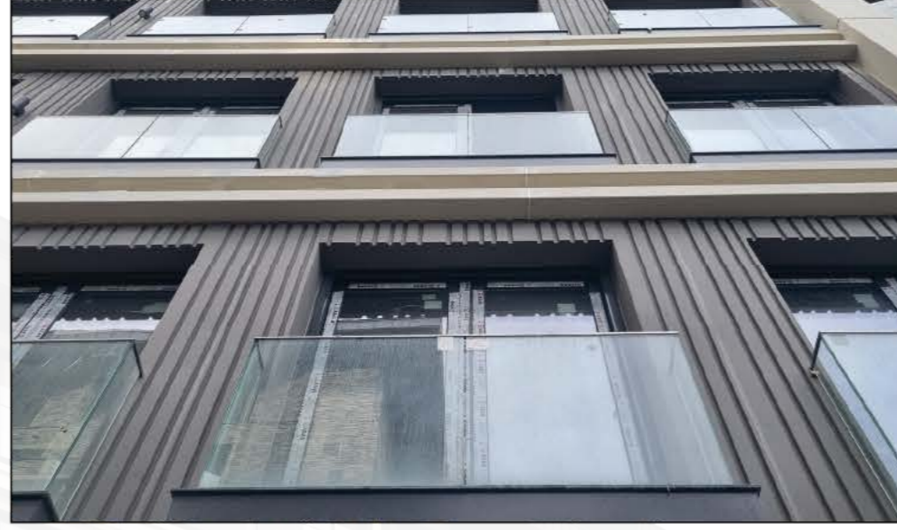
2 Arka Cephe Panel Boyası
