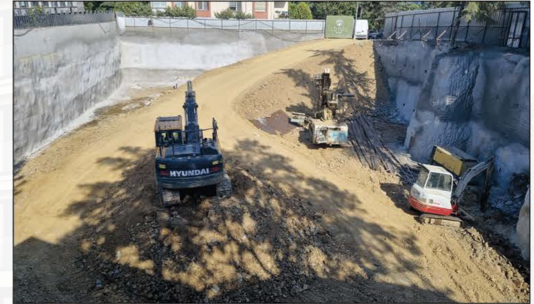
4 Püskürtme Beton Genel Görünüş
