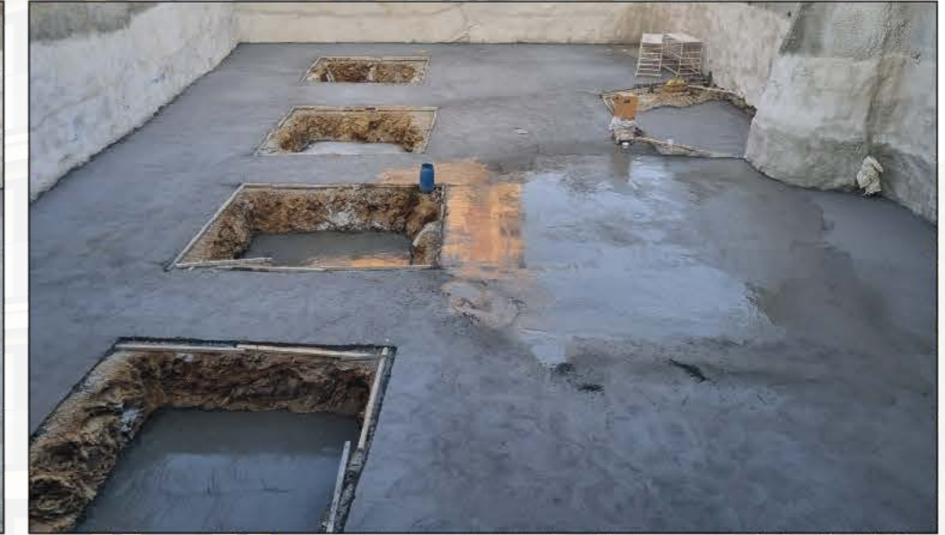
4 Grobeton Genel Görünüş
