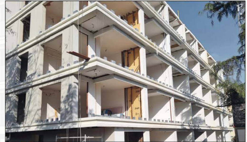
8 Cephe Panel Montajı Dış Cephe Görünüşü
