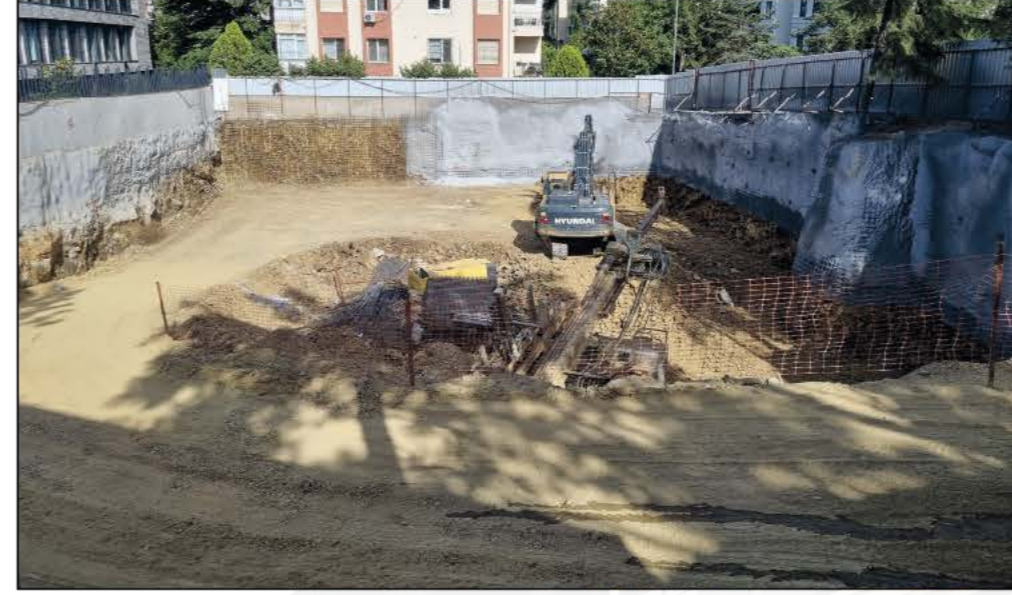
5 Hafriyat Kazısı ve Arazi İçi Nakliye için Güzergah Hazırlanması
