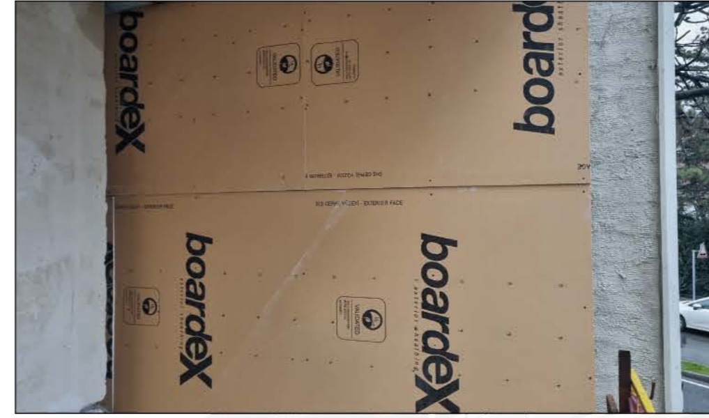
1 Prekast Taşıyıcı Üzeri Tek Kat Boardex İmalatı
