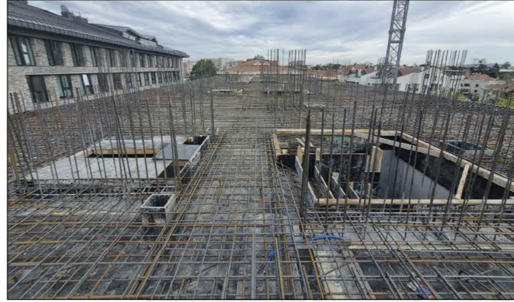
5 Döşeme Donatı İmalatı
