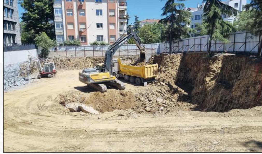
2 Hafriyat Kazısı ve Kırım Yapılması
