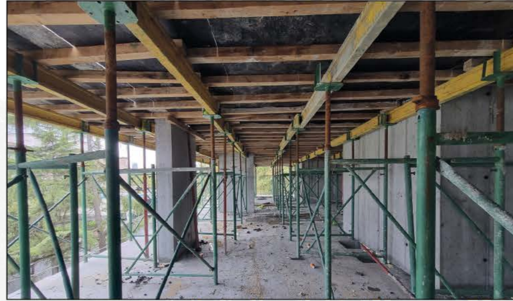
7 Döşeme Kalıp İmalatı
