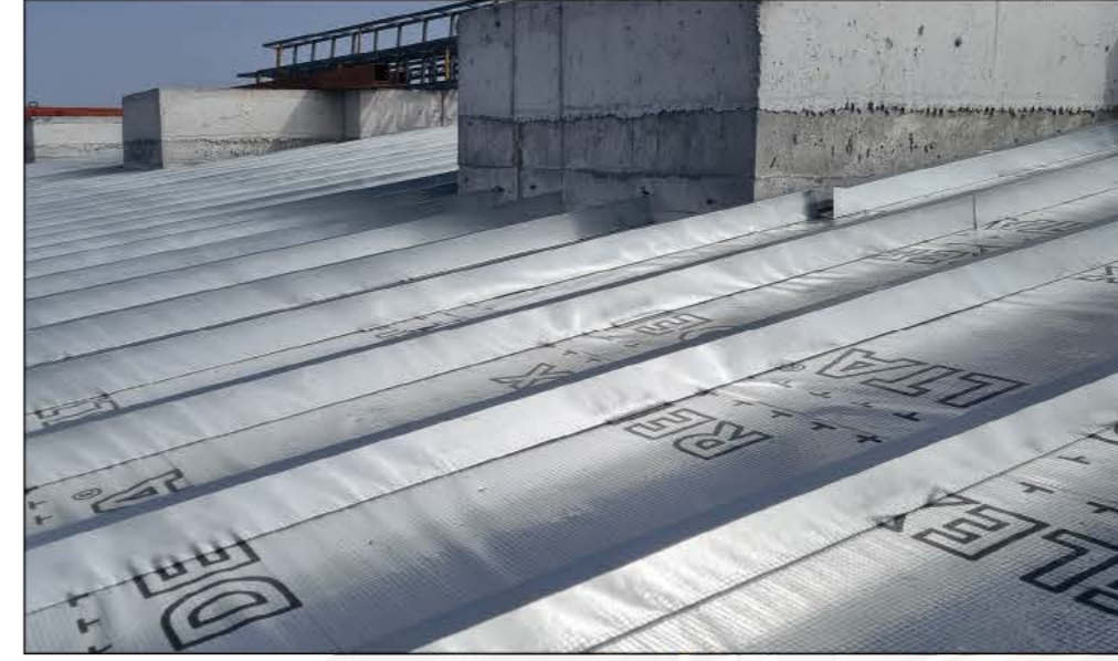
1 Delta Reflex Buhar Kesici Örtü ve Zet Profil İmalatı
