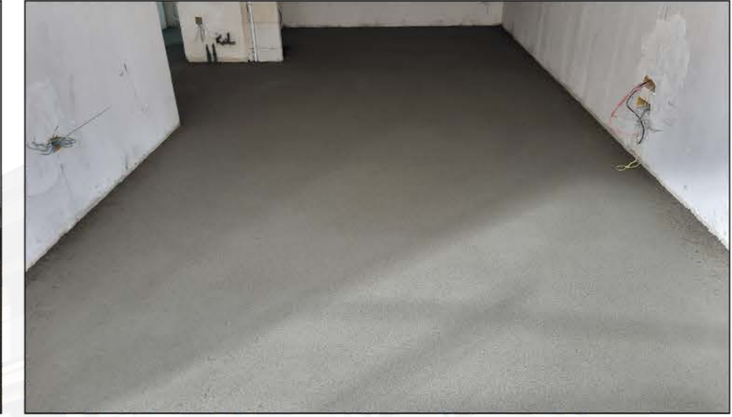
2 Makine ile Kuru Şap İmalatı
