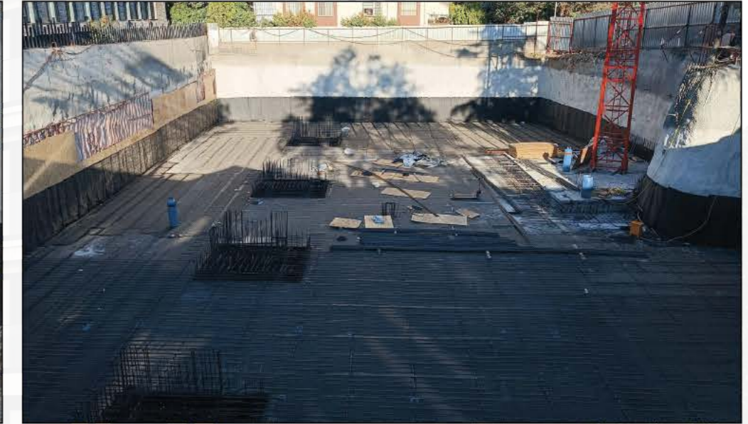
4 Temel Altı İzolasyon ve Perde İzolasyonu Genel Görünüş
