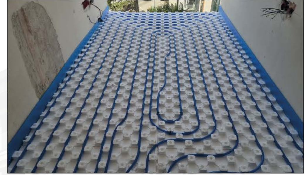
2 Yatak Odaları Yerden Isıtma İmalatı
