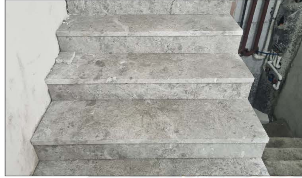
1 Kat Holü Merdiven Düz Basamak Mermer İmalatı
