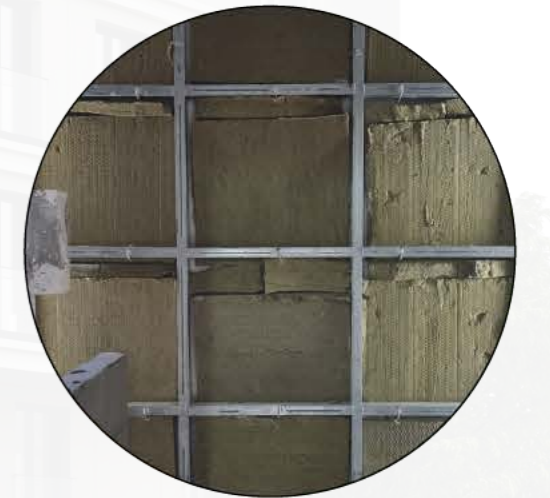
GRC PREKAST CEPHE PANELİ DAİRE İÇİ GÖRÜNÜŞÜ - Taşıyıcı Montajı -
