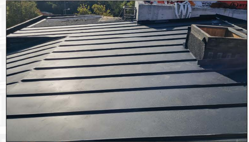
4 Alüminyum Kenet Çatı İmalatı
