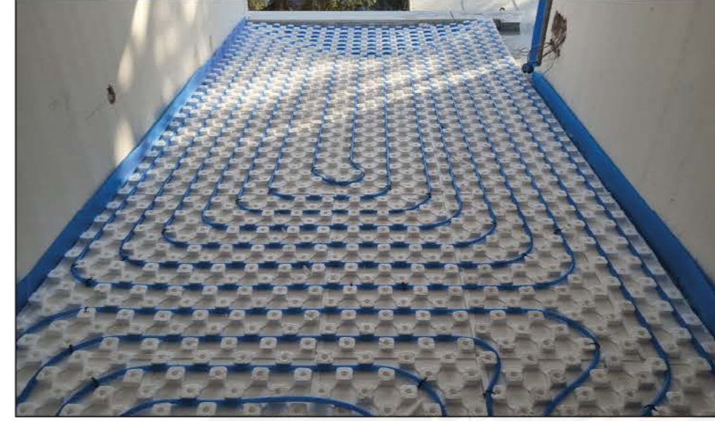
1 Salon Yerden Isıtma İmalatı
