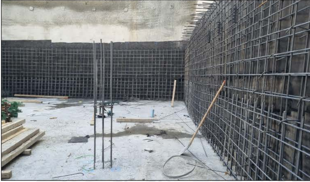
1 Çevre Perde Duvarı Donatı İmalatı
