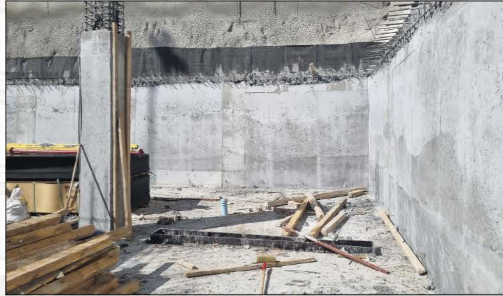
4 Çevre Perde Duvarı Beton İmalatı
