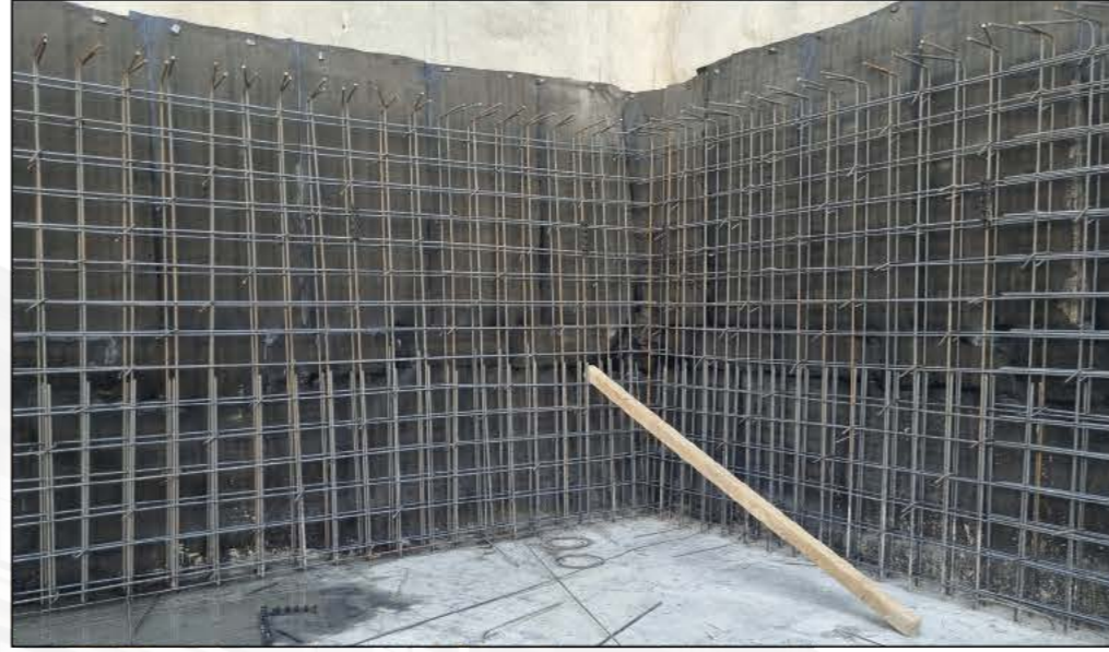
2 Çevre Perde Duvarı Donatı İmalatı
