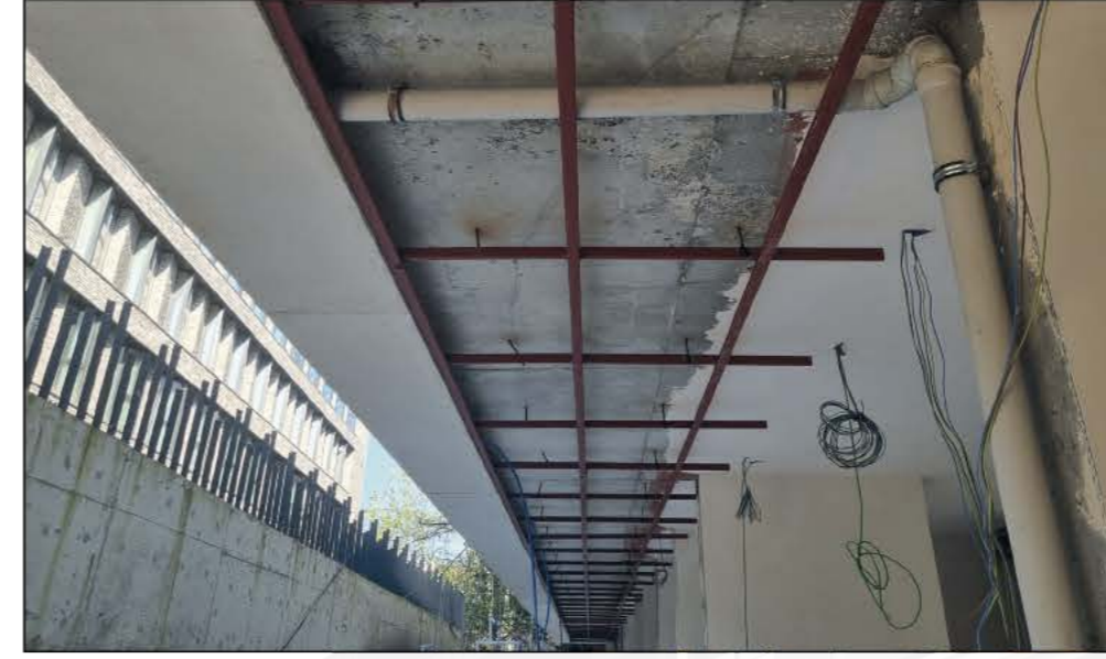
1 Kutu Profil ile Dış Cephe Asma Tavan Karkası
