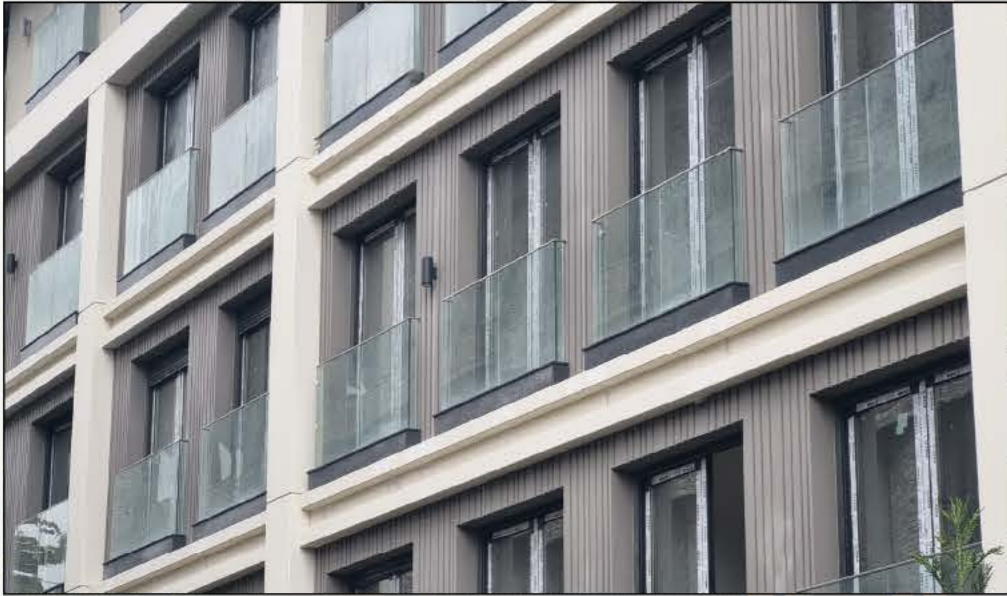
3 Arka Cephe Panel Boyası
