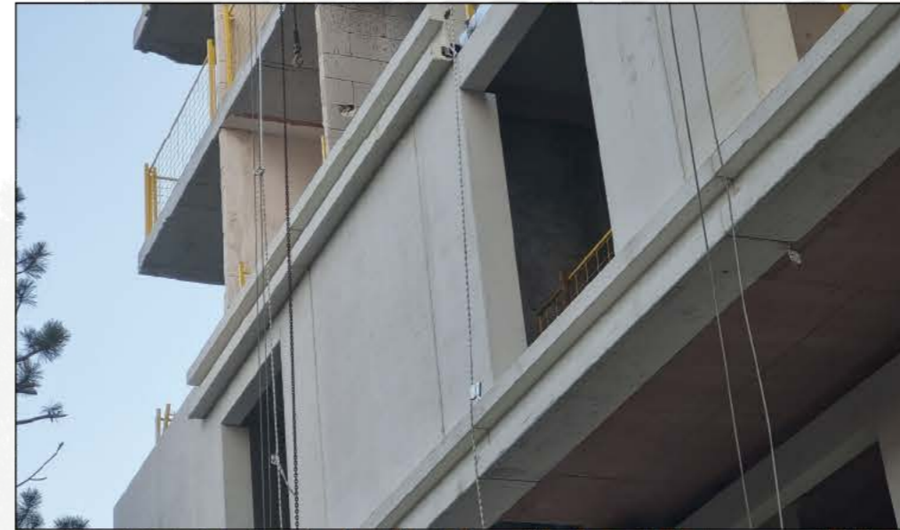
7 Cephe Panel Montajı Dış Cephe Görünüşü
