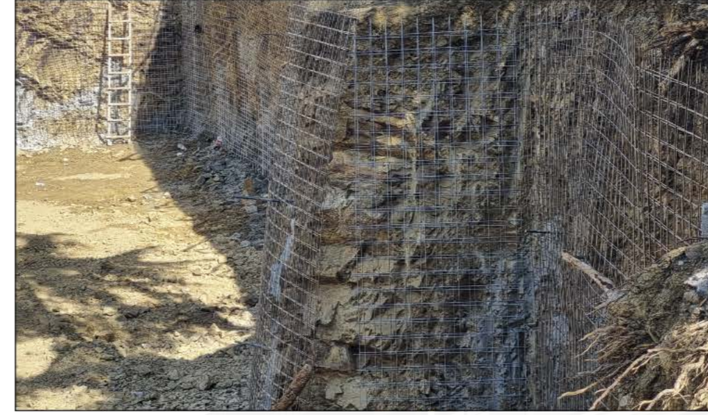
1 Çelik Hasır Döşenmesi
