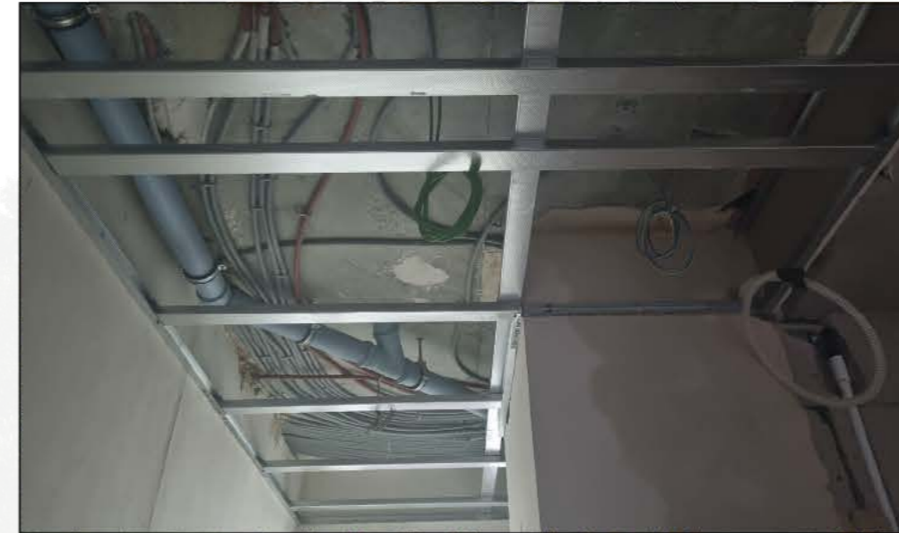
3 Galvaniz Profil ile Daire İçi Asma Tavan Karkası
