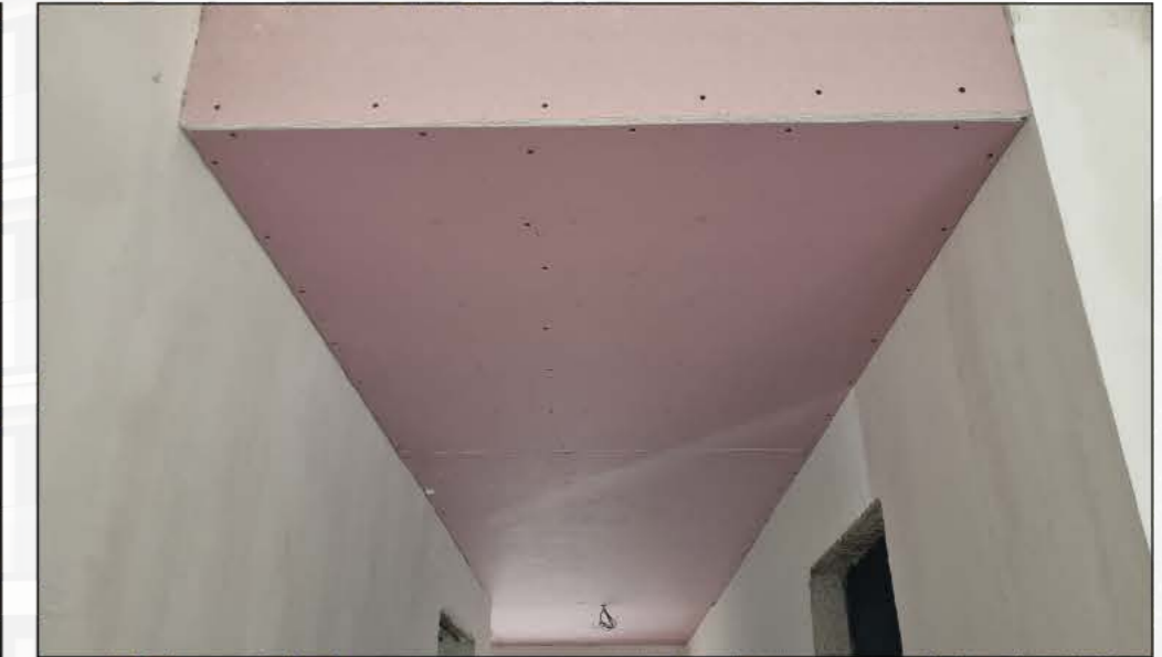
4 Kirmızı Corex ile Daire İçi Asma Tavan Kaplaması
