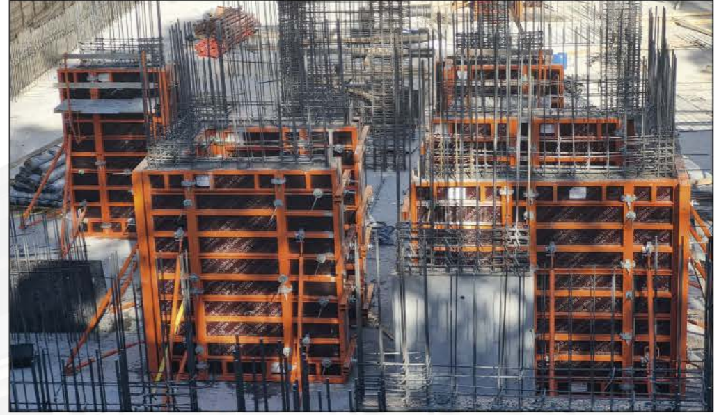
6 Kolon ve Perde Kalıp İmalatı
