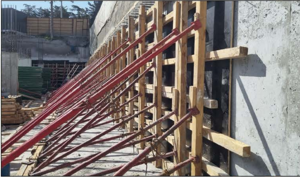
3 Çevre Perde Duvarı Kalıp İmalatı
