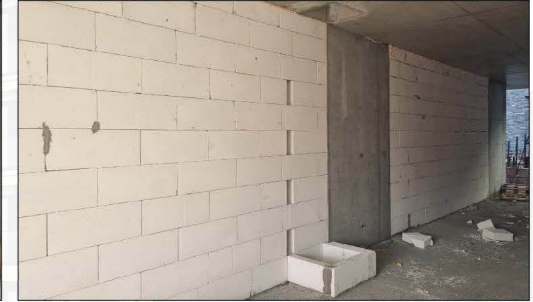
8 Gazbeton Blok Duvar ve Poliüretan Yanmaz Köpük Bitmiş
