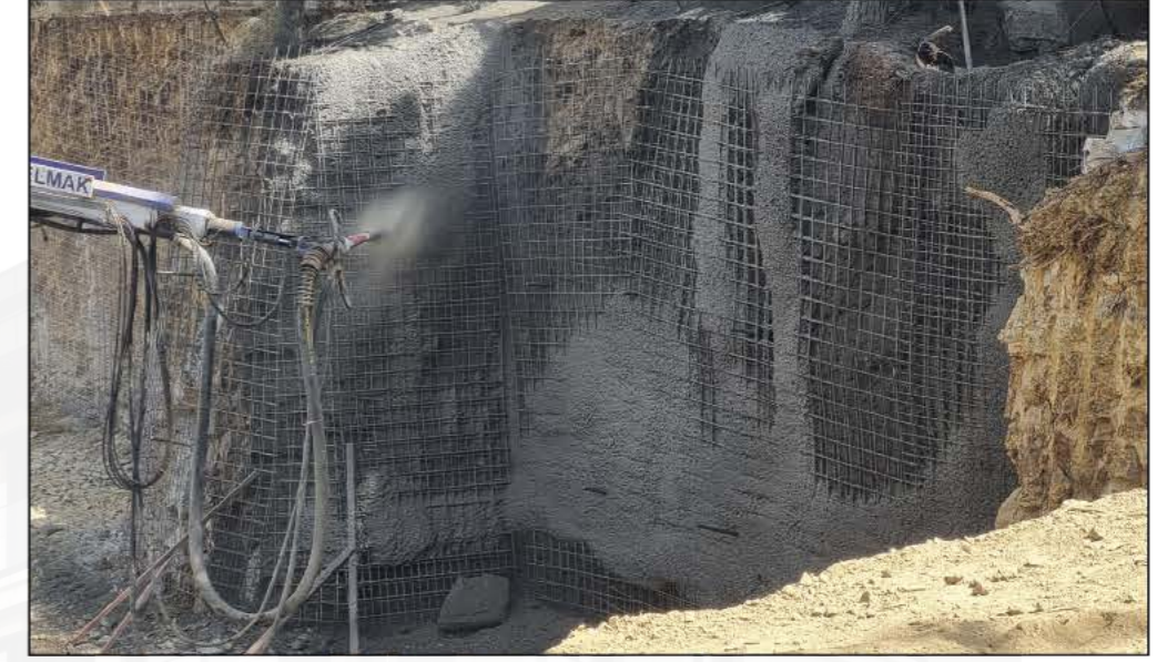
2 Betonsa Shotcrete İmalatı
