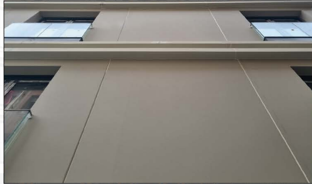
4 Sağ Cephe Panel Boyası
