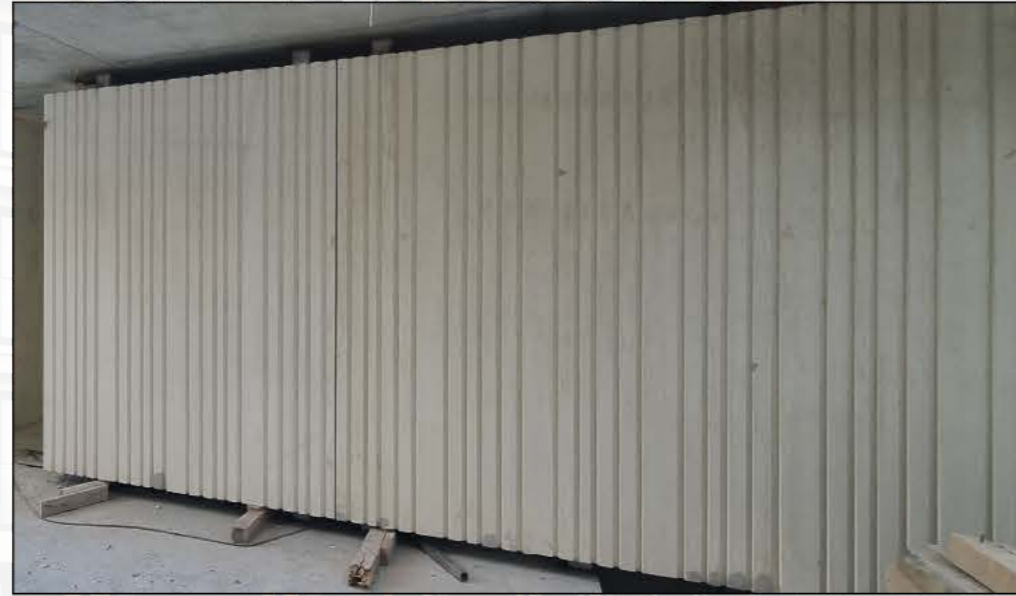
4 Fugalı Panel Montajı Dış Cephe Görünüşü
