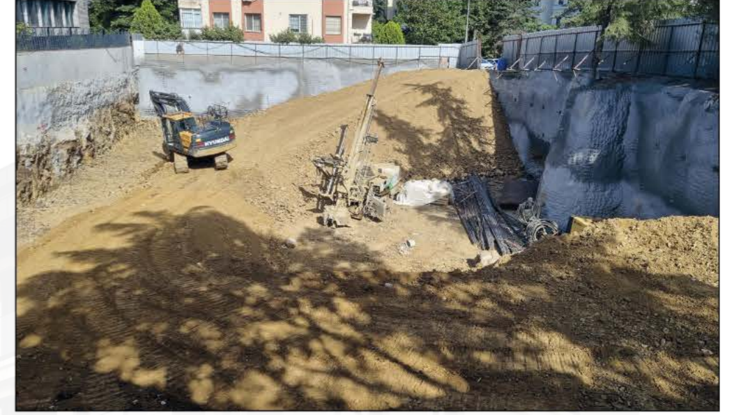
6 Hafriyat Kazısı ve Arazi İçi Nakliye için Güzergah Hazırlanması
