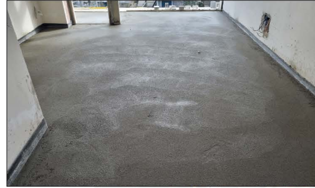
1 Makine ile Kuru Şap imalatı
