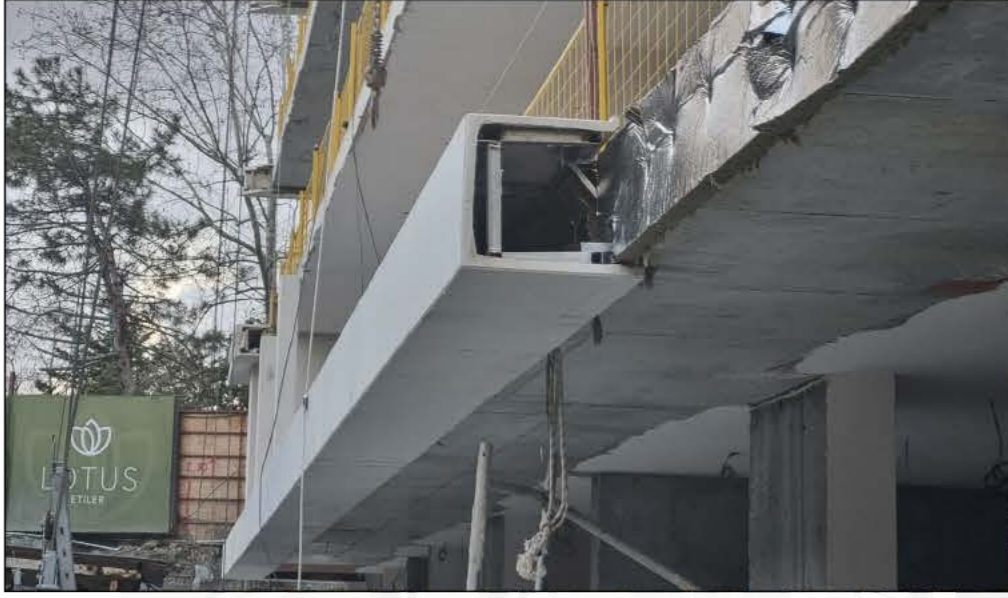
1 Kat Silmesi ve Taşyünü Montajı
