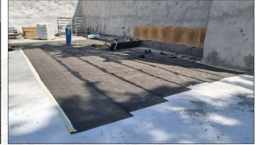
2 Grobeton Üzerine Yalıtım Membranı Serilmesi
