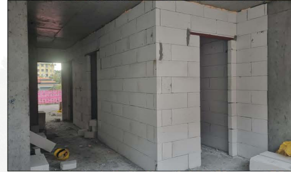
7 Gazbeton Blok Duvar ve Poliüretan Yanmaz Köpük Bitmiş
