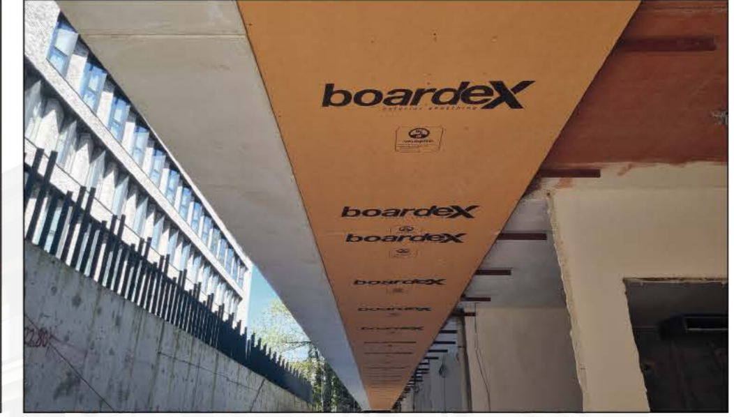
2 Boardex Dış Cephe Asma Tavan Kaplaması
