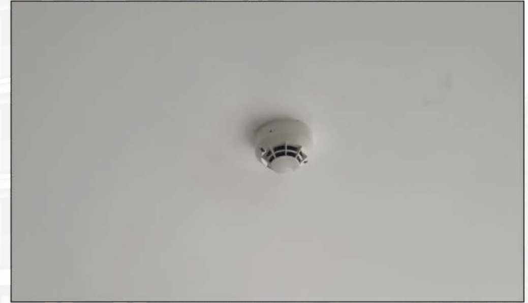
8 Daire İçi Yangın Algılama Sistemi
