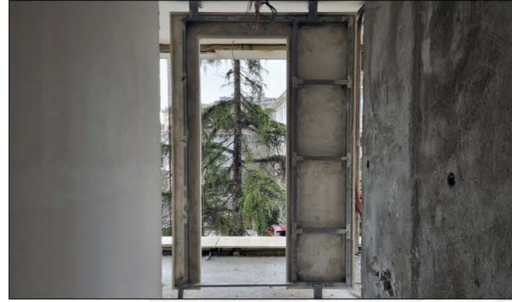
5 Cephe Panel Montajı İç Cephe Görünüşü
