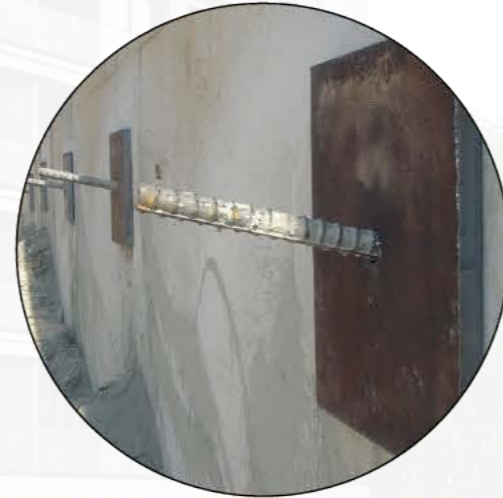
Shotcrete Ankraj Çivisi Q26
