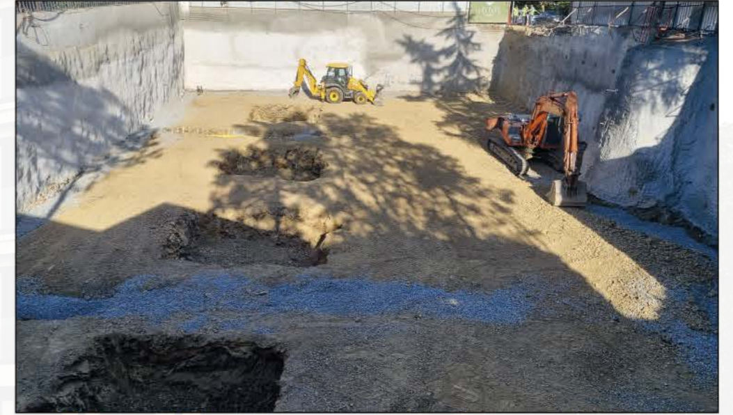
8 Hafriyat Kazısı ve Asansör Kuyularının Açılması
