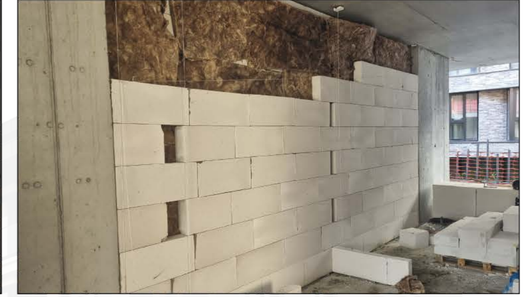
6 Gazbeton Blok Duvar Aplikasyonu ve Taşyünü Montajı
