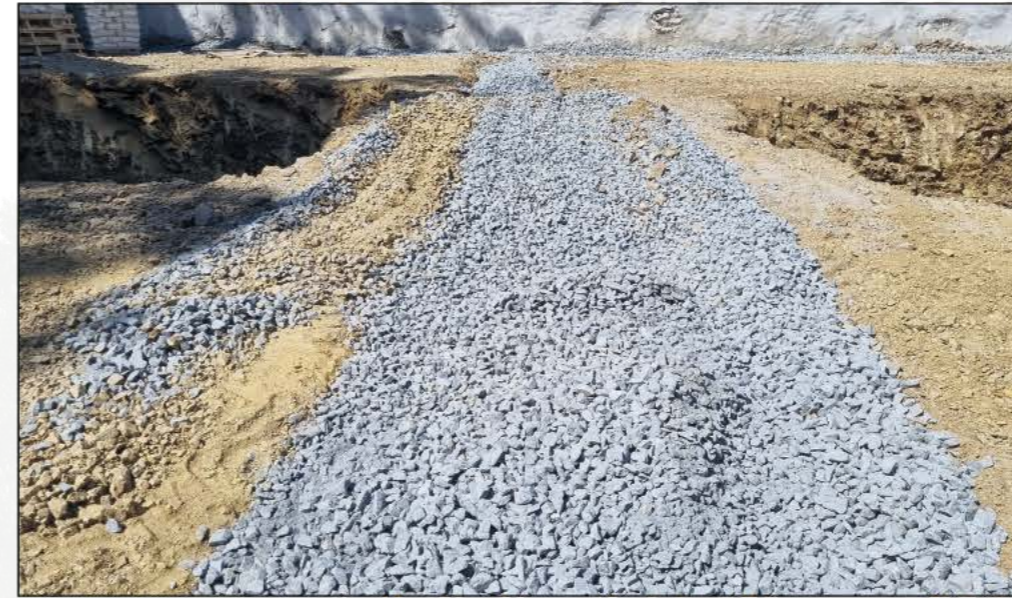
3 Tesviye Mıcırı ile Dolgu Yapılması
