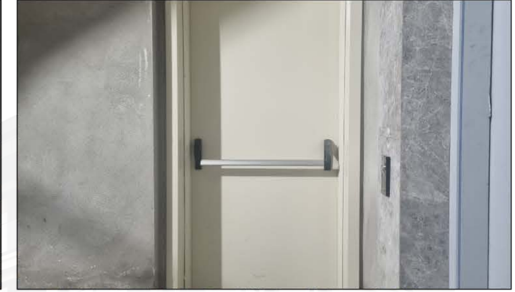
2 Yangın Kapısı Kat Holü Görünüşü
