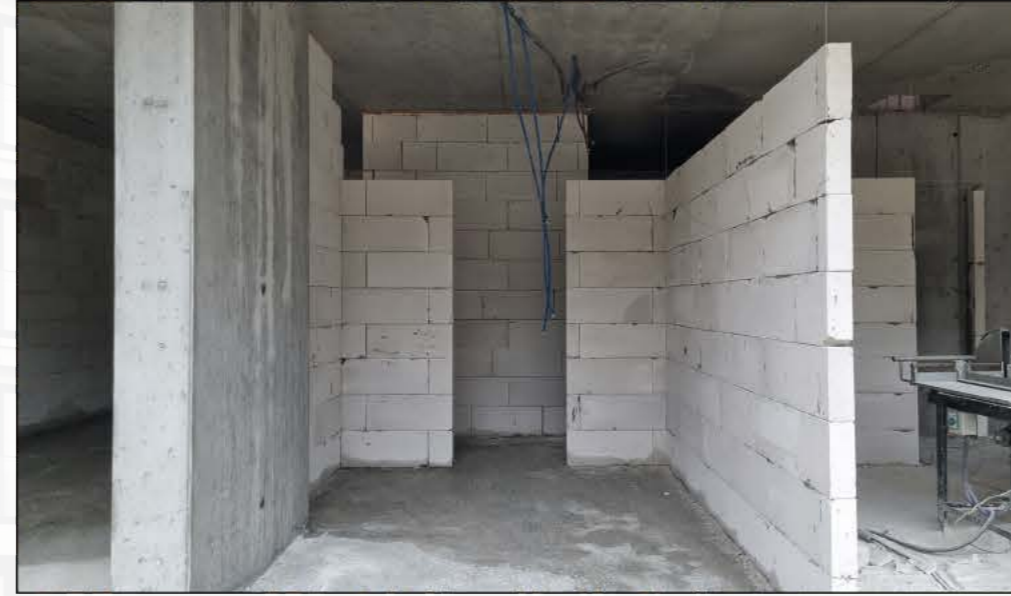
4 Gazbeton Blok Duvar Örülmesi ve Kapi Boşlukları
