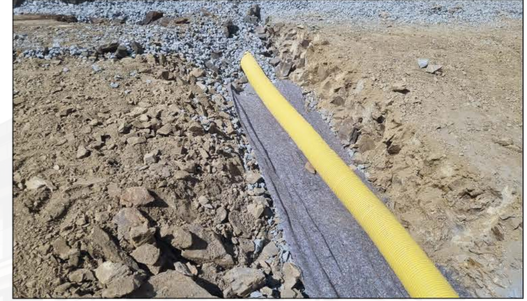
2 Temel Altı Drenaj Borusu Etrafı Geotekstil Keçe Sarılması
