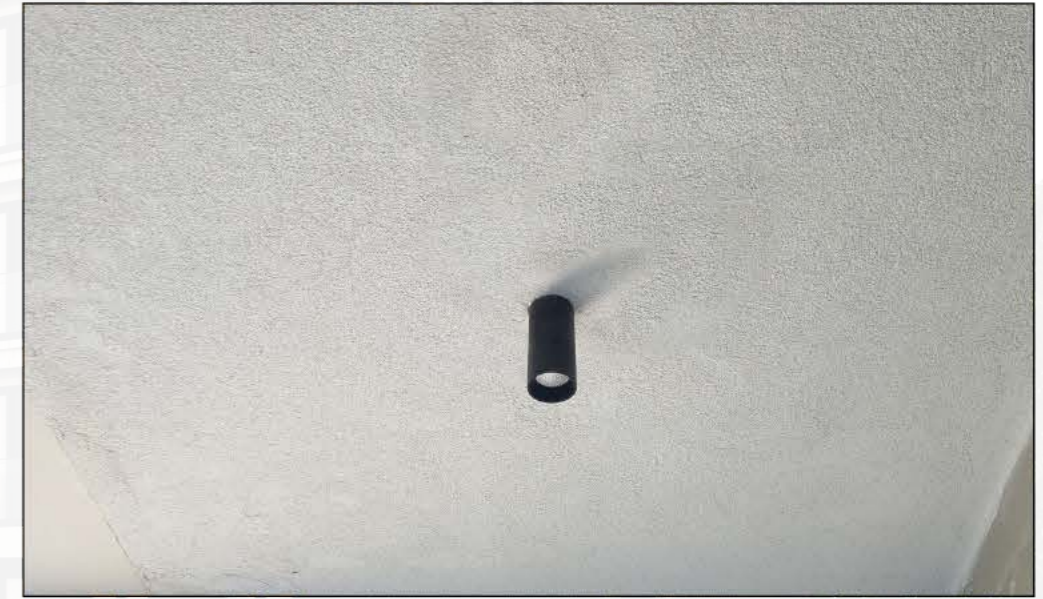
4 Balkon Tavanı Dekoratif Sıva İmalatı
