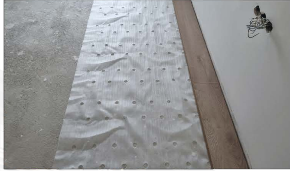
2 Parke Şiltesi ve Parke Montajı
