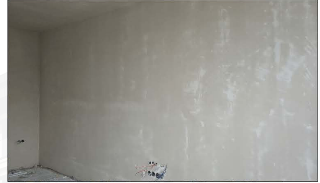
2 Daire İçi Duvar Saten Sıva İmalatı
