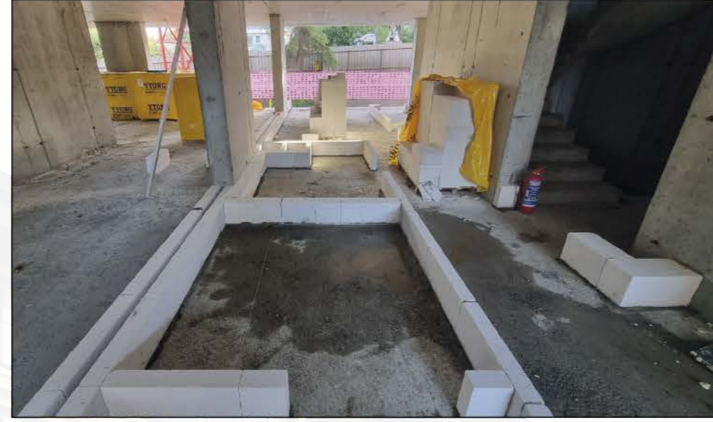
2 Gazbeton Blok Duvar Aplikasyonu
