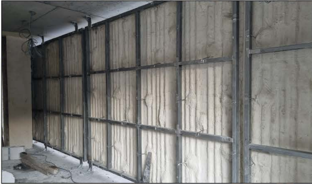
3 Fugalı Panel Montajı İç Cephe Görünüşü
