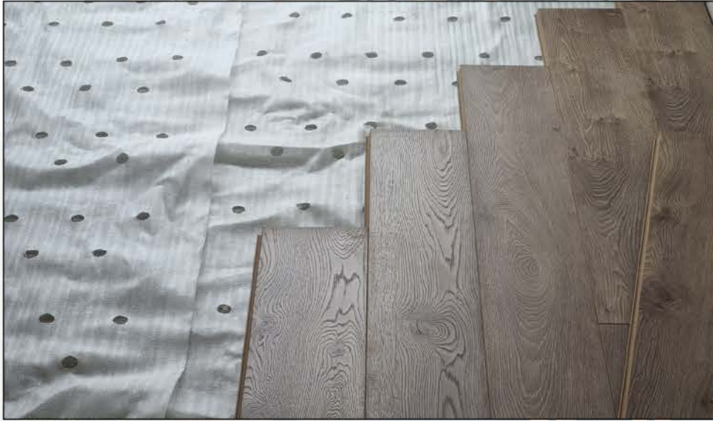
3 Parke Şiltesi ve Parke Montajı
