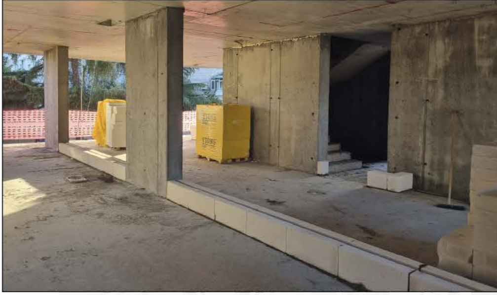
1 Gazbeton Blok Duvar Aplikasyonu
