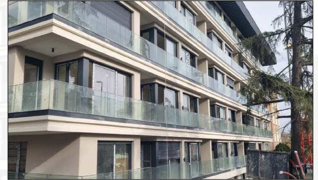
8 Ön Cephe Panel Boyası
