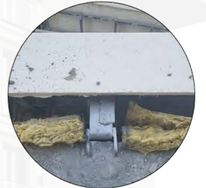
Detay 2 Kat Silmesi Ankraj Detayı
