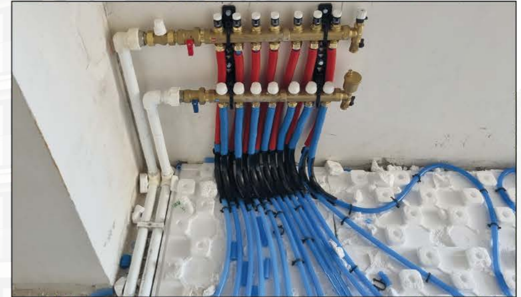
4 Yerden Isıtma Kollektör Bağlantısı
