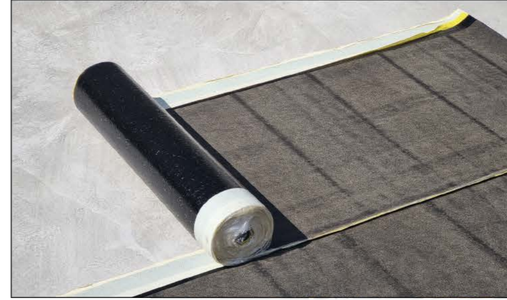
1 Grobeton Üzerine Yalıtım Membranı Serilmesi
