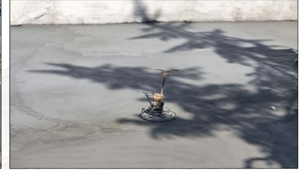
2 Grobeton Yüzeyinin Düzeltilmesi
